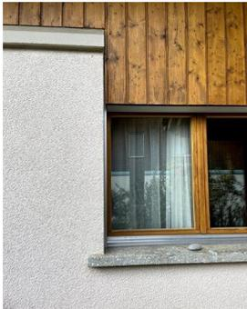
Wärmebrücken bestehen im Sockelbereich zwischen Keller und EG, bei den Anschlüssen der Wände an die Kellerdecke sowie bei den Storenkästen. Die Fenster weisen die üblichen Wärmebrücken in den Fensteranschlüssen auf. Die Balkone sind in Holzbauweise und daher wärmebrückenfrei.
